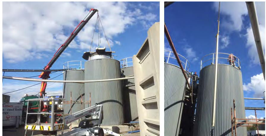
Bild 3: Installation der Anammoxreaktoren auf einer 550 000 EW Anlage in Schweden zur Hauptstrombehandlung © Kompetenzzentrum Wasser Berlin gGmbH
