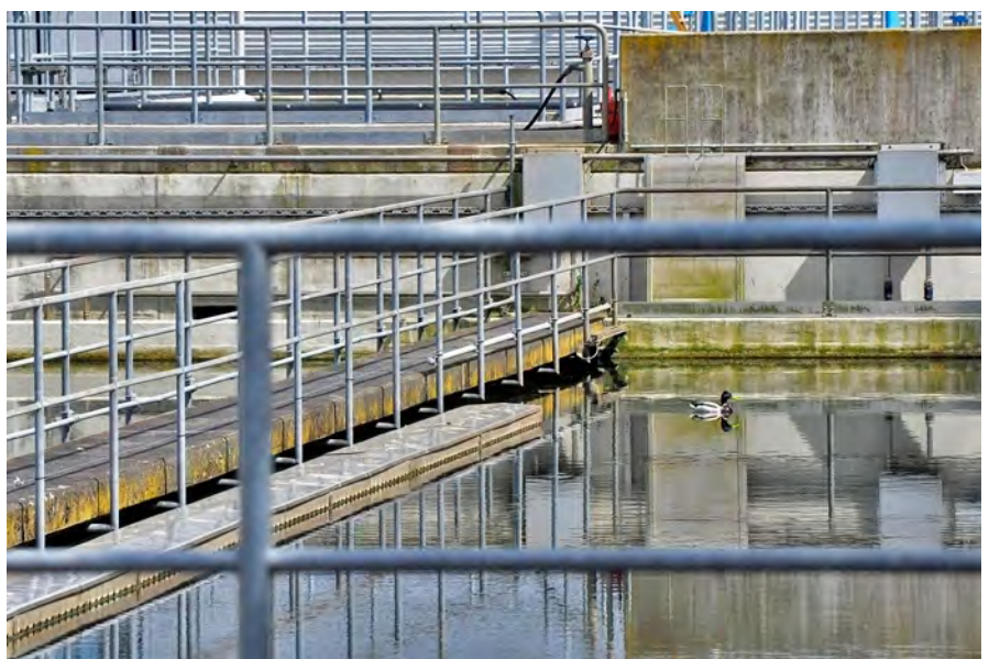
Nachklärbecken einer Kläranlage © Kurt Michel / pixelio.de
