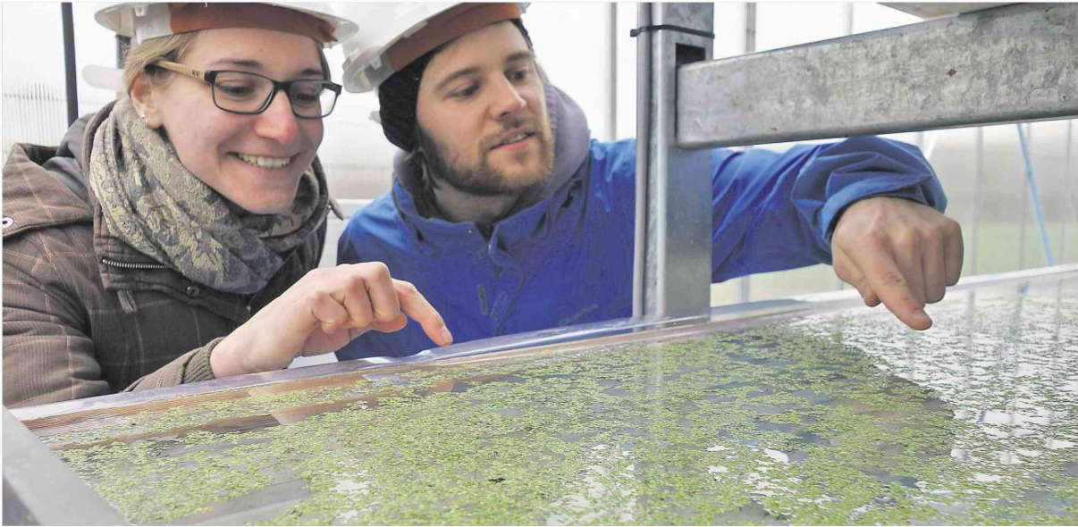
Stephan Baillieu (v.l.), Geschäftsführer des AZV, Rabea-Luisa Schubert und Christian Loderer vom Kompetenzzentrum Wasser stehen an der Mikrosiebanlage. Das Wasser, das die Siebe durchlassen, ist von fast allen Feststoffen befreit.
